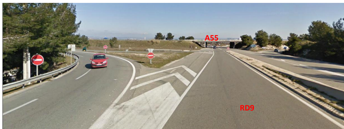
Vue vers le Nord depuis l'RD9 au niveau de l'échangeur (Google – streetview)
