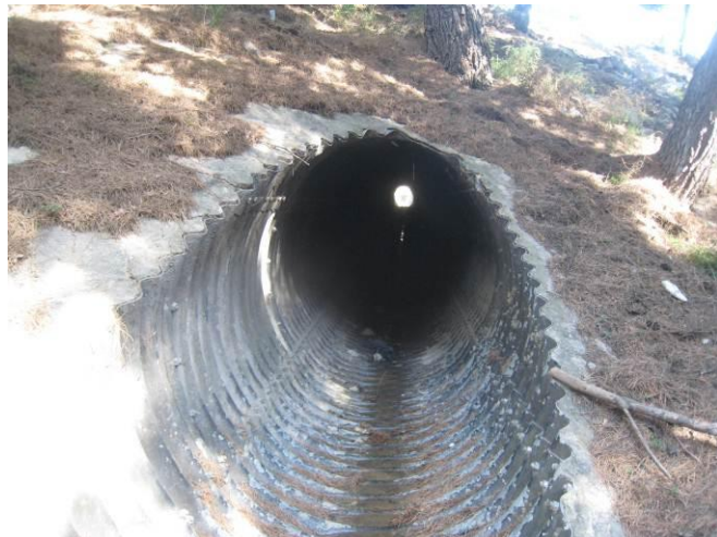
Ouvrage hydraulique sous la RD9 – EGIS France
