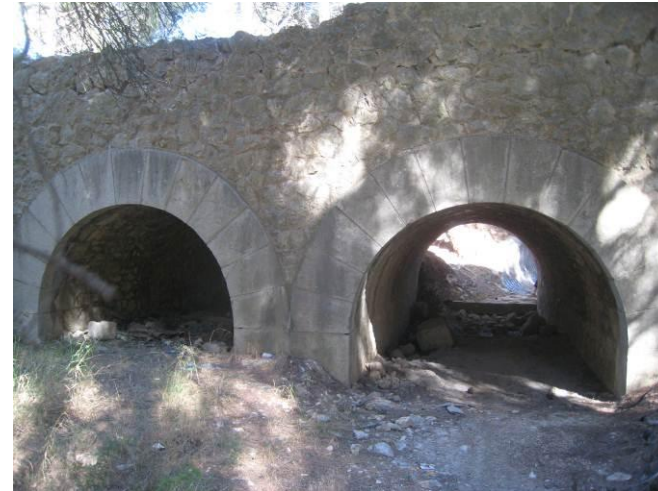
Ouvrage hydraulique sous le chemin d'accès à la propriété située entre la RD9, RD9d et l'A55 – EGIS France
