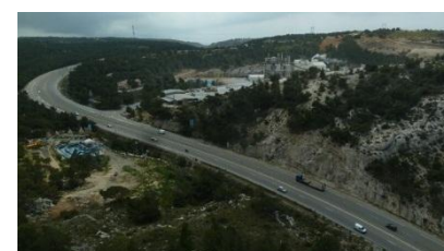
Vue vers le Sud de la RD9
