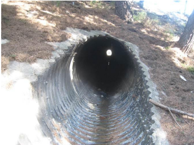
Ouvrage hydraulique sous la RD9 – EGIS France
