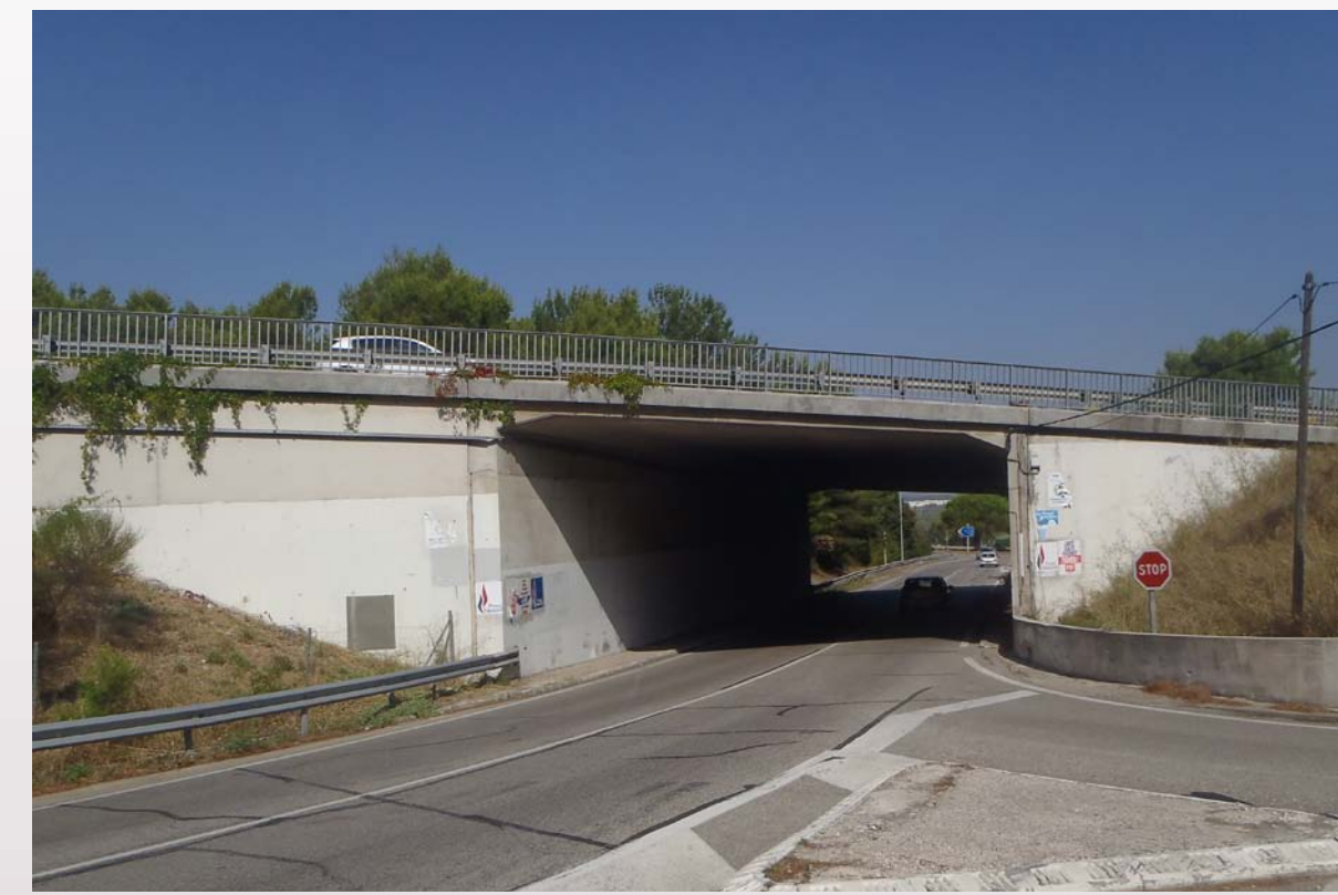
⇒ Infrastructures : RD559a franchie par l'autoroute.
