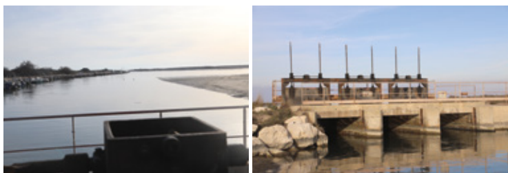
C'est par le petit port du Grau de la dent et ses 3 martelières que vont transiter 50 millions de m 3 d'eau de la mer aux étangs
