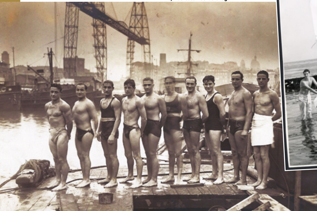
En repli au bassin du Carénage 1927 © DR
