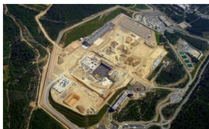
Plateforme ITER – source : www.iter.org
