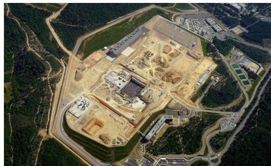
Plateforme ITER – source : www.iter.org
