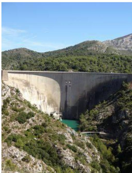
Notre circuit nous conduit vers le barrage de Bimont : il se dresse comme une immense falaise ; un écoulement en bas permet d'alimenter un minuscule barrage en dessous : l'eau est conduite vers un canal qui permet de sécuriser le niveau d'eau pour la ville d'Aix.
