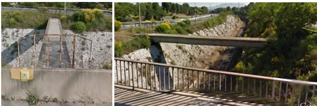
PASSAGE AN AÉRIEN DIAMÈTRE 150MM GAZ AU-DESSUS VOIE FERRÉE
