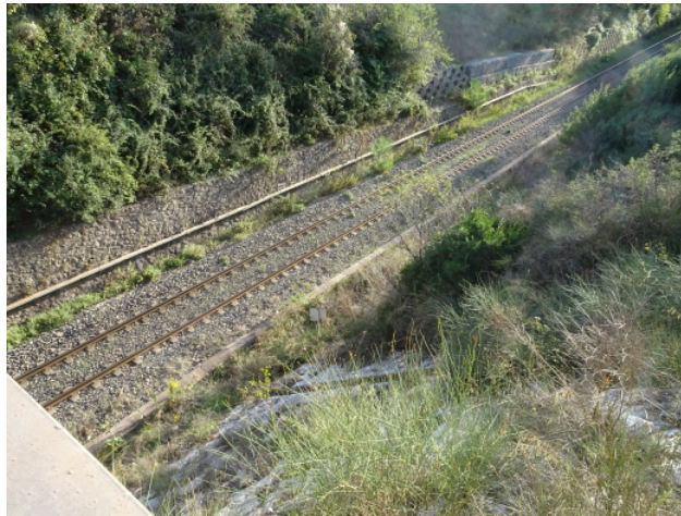
Vue de la voie ferrée depuis l'échangeur (ouvrage supérieur) avec murs en gabions côté sud et mur en pierres côté nord (EGIS © 2020)
