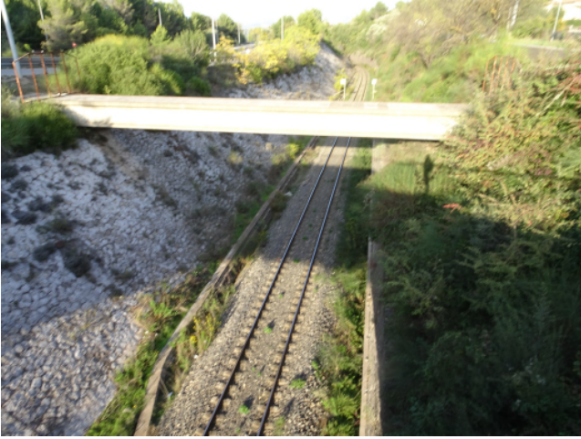
Vue de la voie ferrée depuis l'échangeur, en déblais de la RD6, avec mur de soutènement en pierre maçonnée (EGIS © 2020)
