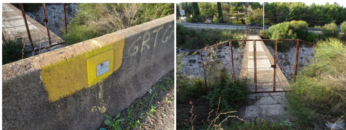
FIGURE 29 - TRAVERSÉE DE LA CANALISATION DE GAZ COUVERTE AU-DESSUS DE LA VOIE FERRÉE (EGIS © 2020)
