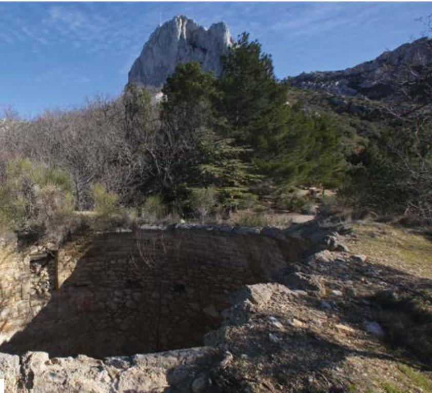
D'un diamètre de 14,6 mètres et d'une profondeur de 16 mètres, la glacière du Pic de Bertagne existe encore de nos jours.
