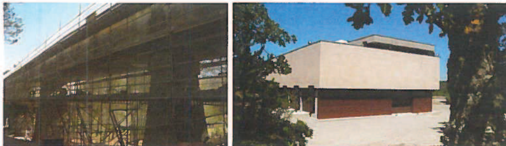
La station de pompage de Ginasservis dans le Var
