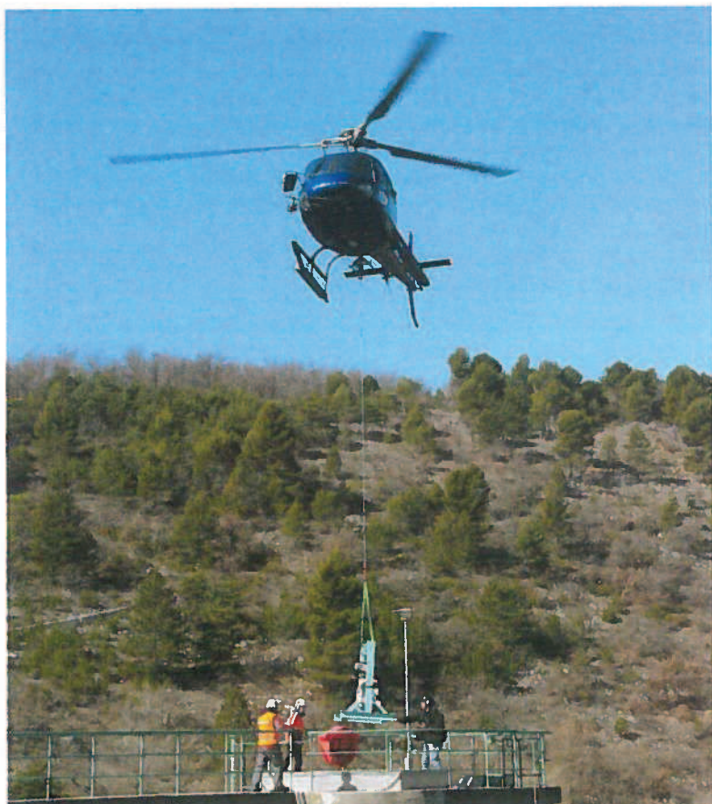
Opération de maintenance par hélitreuillage au barrage de la Laye à Mane, dans les Alpes de Haute-Provence, pour le compte du SIIRF
