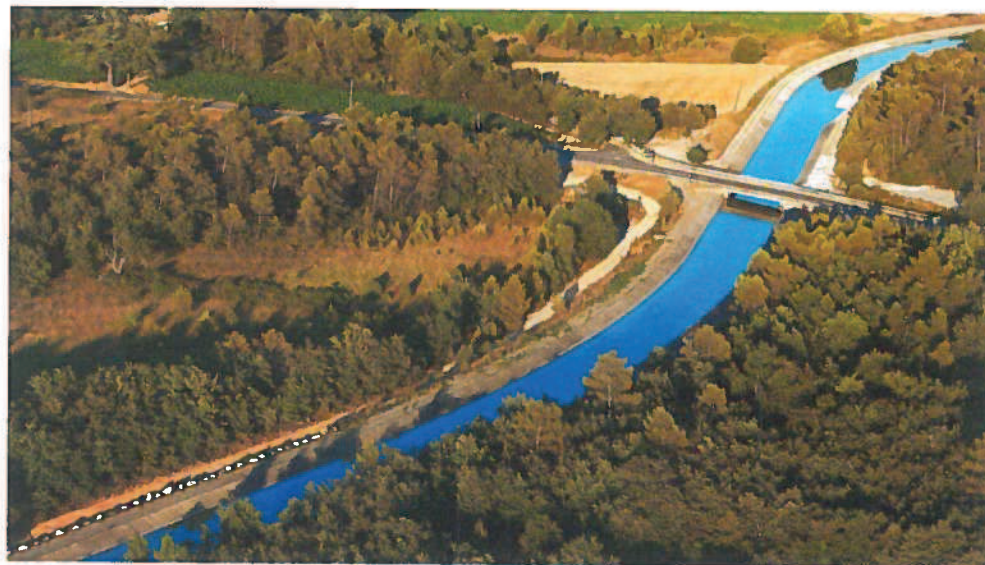
Le Canal de Provence dans le Var à proximité de Signes
