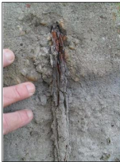
Photo n°4 : Réduction puis destruction d'armatures en bajoyer
