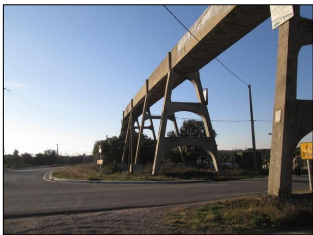
Canal aérien au croisement entre la RD83 et la RD27
