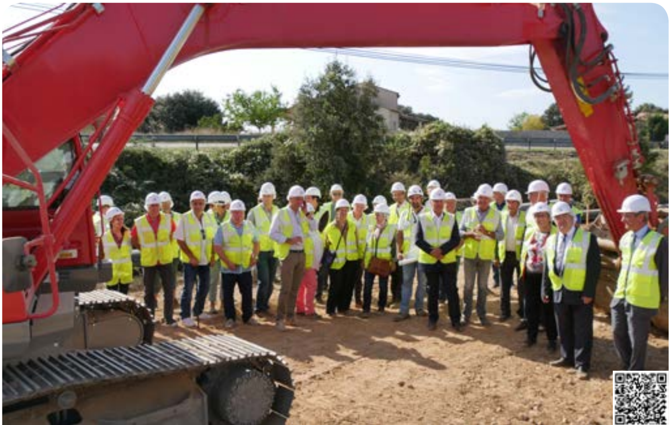
Visite du chantier de diversification et de sécurisation de la DLVA dans les Alpes de Haute-Provence
