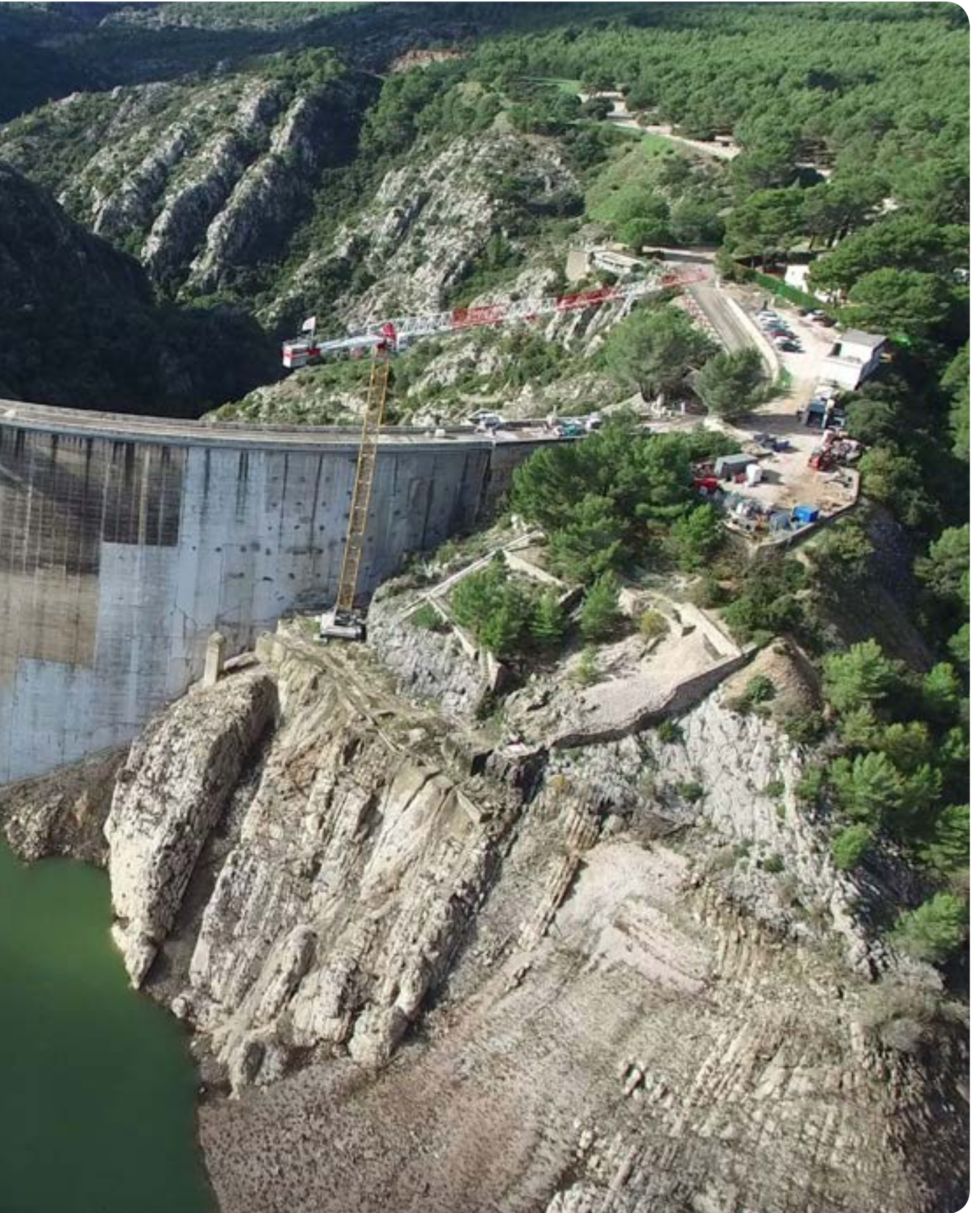
Vue amont du barrage de Bimont pendant l'assec de la retenue
