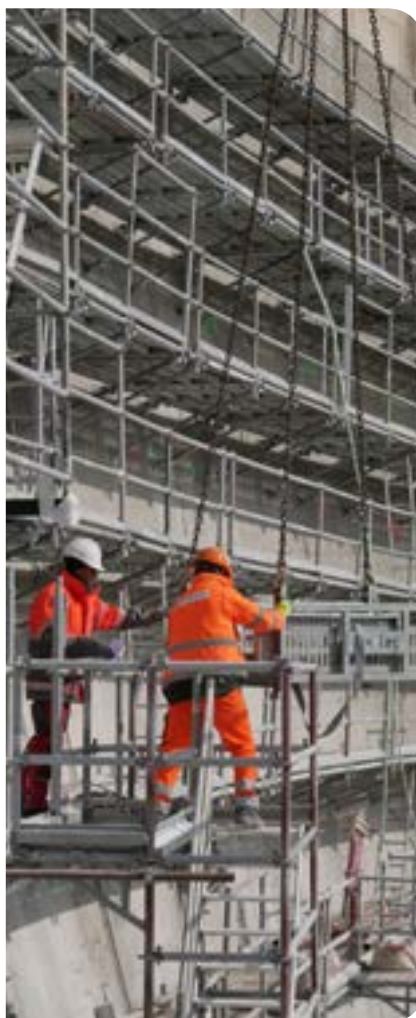
Echafaudages du barrage de Bimont
