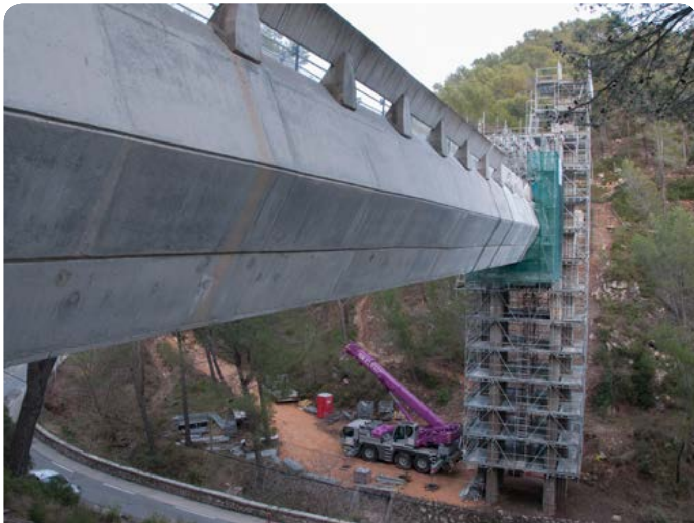
Rénovation de l'aqueduc de la Fève dans les Bouches-du-Rhône
