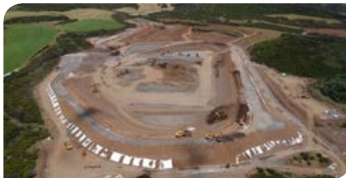
Chantier de la retenue collinaire de Piton Rouge à La Réunion
