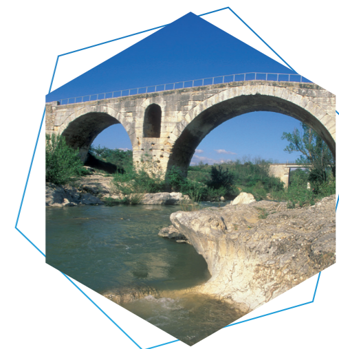
Pont Julien, Calavon-Coulon
