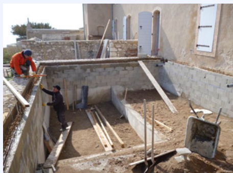
Préparation du bassin avant la pose de la membrane
