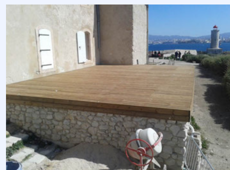
Vue du bassin après pose du bardage bois
