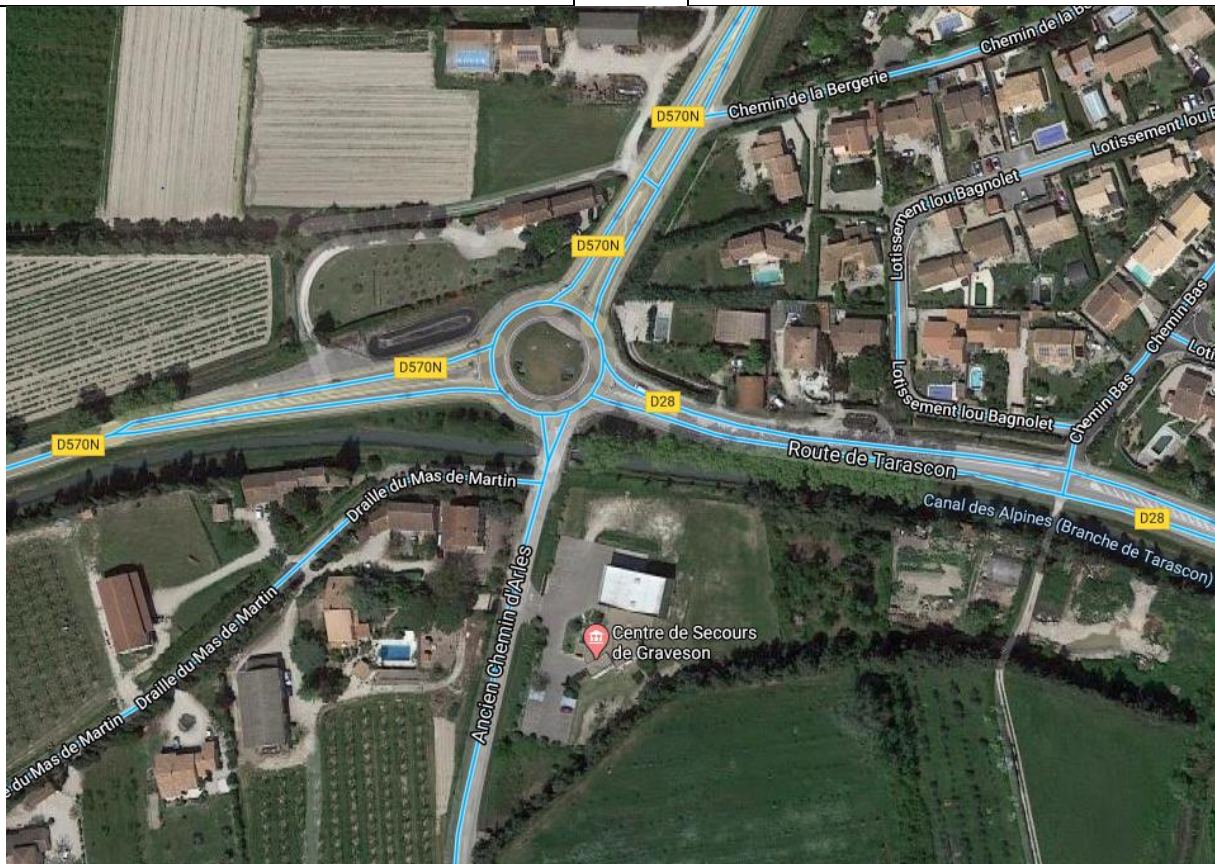
Vue aérienne du rond-point de Millet
