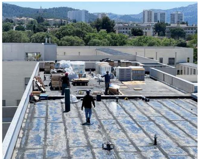
*Au collège Gyptis (Marseille, 9<sup>e</sup>), les travaux d'isolation des toits ont démarré au printemps dernier.*
